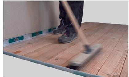
2. Verlegen eines entsprechend geeigneten und ausreichend dimensionierten Estrich-Randdämmstreifen zu allen aufgehenden Bauteilen.
