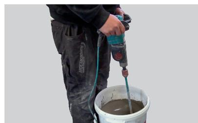
Bei dem Einbau der Spachtelmasse ist auf die richtige Höhenlage und die entsprechende Schichtdickenvorgabe zu achten
