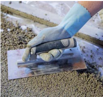
Verarbeitung des Leichtestrich-Systems ARDEX Stronglite
