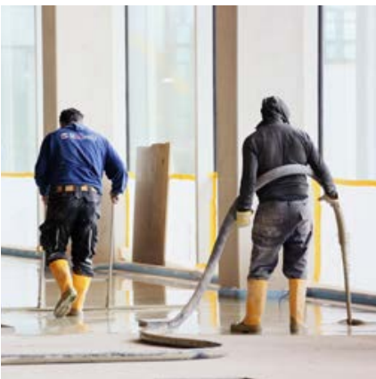
ARDEX-Verarbeiter bei der Herstellung einer Bodenfläche
