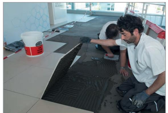
An einigen Stellen konnten die neuen Fliesen nicht auf den alten verlegt werden – die Handwerker mussten sie komplett herausstemmen. Danach wurde der Untergrund mit der Haft- und Grundierdispersion ARDEX P 51 im Mischverhältnis 1 : 3 vorbereitet und anschließend mit der Ausgleichsmasse ARDEX-Spachtelmasse nivelliert. Darauf verlegten Gunia und sein Team dann die großformatigen Fliesen – wieder auf ARDEX S 28.
