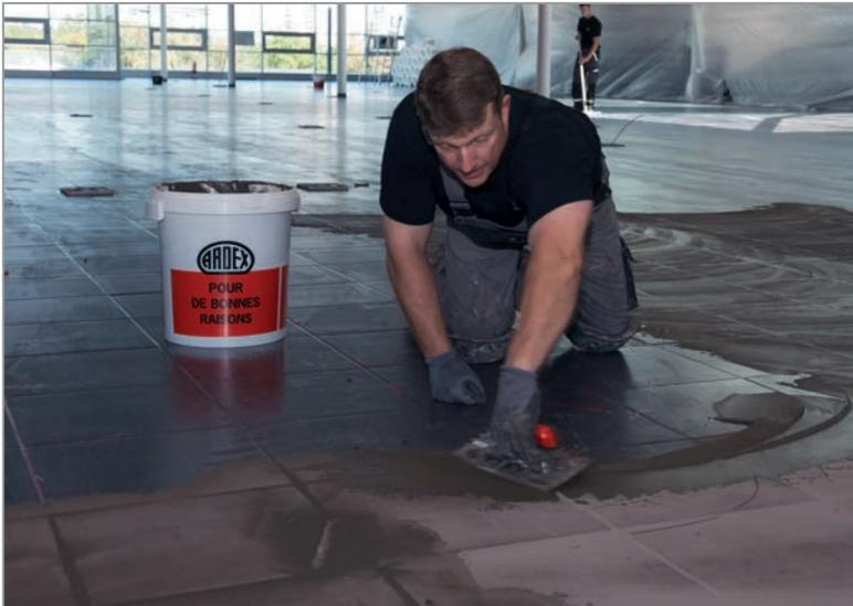
Als Grundierung kam danach der zweikomponentige Kunstharzanzstrich ARDEX P 82. Darauf verlegten die Handwerker großformatige Feinsteinzeugfliesen mit dem MICROTEC Großformatkleber ARDEX S 28 neu.
