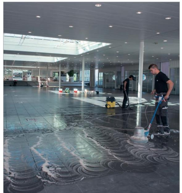
In der Neuwagenausstellung sowie in einem Teil des Empfangs und der Verbindungsbrücke zwischen Gebrauch- und Neuwagenbereich konnten die neuen Beläge auf den bestehenden Fliesen verlegt werden. Dazu mussten diese jedoch zunächst gründlich gereinigt werden. Im ersten Schritt wurde der Bodenbelag mit einem Spezialreiniger gesäubert, dann geschliffen und zuletzt abgesaugt.
