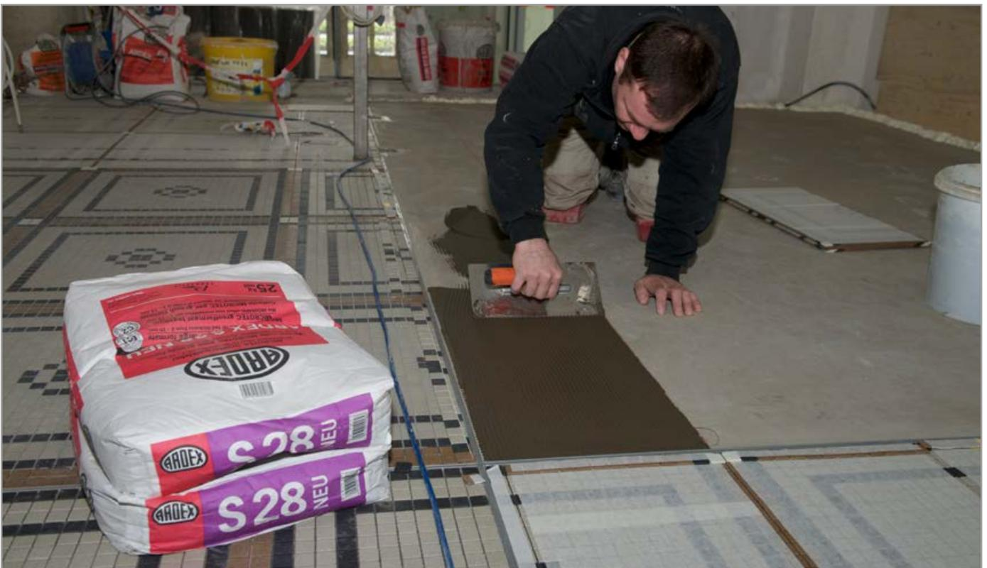
Die Mosaikverlegung stellte besondere Anforderungen an den Fliesenkleber: Er sollte einerseits eine lange Einbettungs- und damit Verarbeitungszeit ermöglichen. Andererseits sollte er bereits am nächsten Tag fest genug sein, um die Frontseitenfixierung entfernen zu können. Die Lösung war der Großformatkleber ARDEX S 28 NEU.
