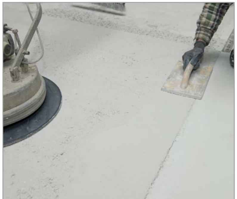
An das Mosaik grenzt ein weißer Terrazzo-Boden an. Die saubere und schnelle Ausführung gelang mit PANDOMO® PW/PB Bindemittelmatrix in Weiß. Mit diesem Bindemittel von Ardex lassen sich zementäre, schnell nutzbare Dekorböden in Terrazzo-Optik herstellen. Schon zwölf Stunden nach Verarbeitung ist der Boden begehrbar.
