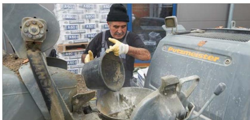
Zum Einsatz kam der hochbelastbare Schnellestrich-Zement ARDEX A 60. Dieser wurde im Verkaufsraum auf einer Fläche von rund 560 qm auf 3 cm Styrodur-Dämmung verlegt. Die Fläche wurde mit Fugen in einzelne Felder von rund 50 bis 90 qm aufgeteilt. Dafür wurden Stahlprofile eingebracht und der Estrich dann bis zur Aufbauhöhe von etwa 7 cm eingebracht.
