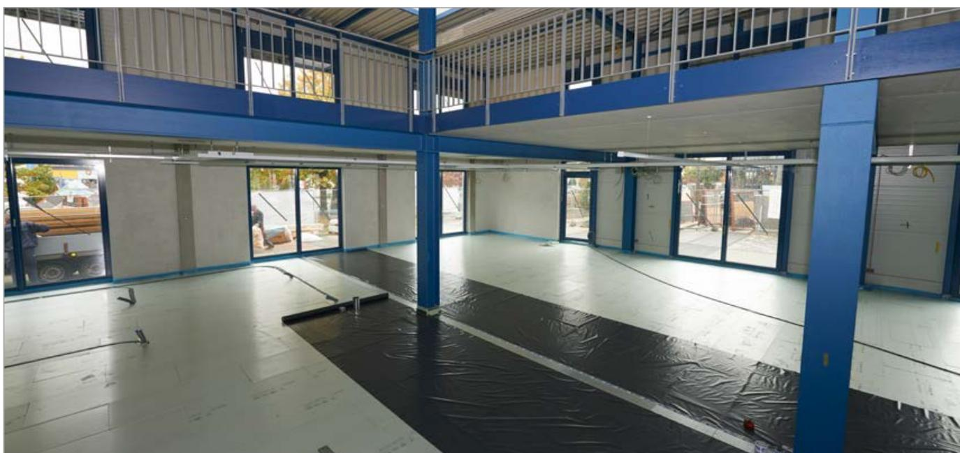
Das alte Fundament konnte wieder genutzt werden, die Bodenplatte blieb erhalten. Aufgrund des schlechten Baugrunds musste die Platte jedoch durchgebohrt werden, um neue Stützen zu setzen. Danach wurde der Estrich eingebracht.
