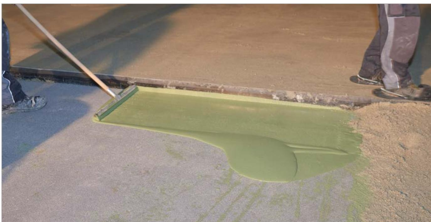
Da der Staplerbereich von Baustoff Sauter noch einmal deutlich höher belastet wird als der Verkaufsraum, wurde ARDEX A 60 hier als Verbundestrich eingebracht. Dazu wurde der Untergrund zunächst mit dem zweikomponentigen Epoxidharz ARDEX EP 2000 gegen aufsteigende Feuchtigkeit abgesperrt und anschließend abgesandet. Als Kontaktschicht wurde die Haftschlämme ARDEX A 18 eingesetzt, um dann den Schnellestrich ARDEX A 60 im Verbund einzubringen.
