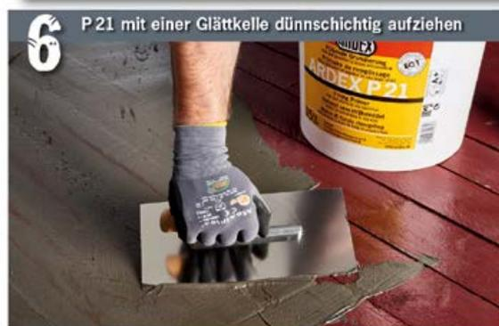
ARDEX P 21 ist als fertiges Set in einem Anrührer gepackt. Auf der Baustelle werden einfach beide Komponenten im Eimer angerührt – im Mischungsverhältnis 2:1. Die fertige Grundierung kann auf allen typischen Untergründen eingesetzt werden. In der Fläche kann das Produkt bis zu 5 mm dick aufgetragen werden, Löcher können bis zu einer Tiefe von 20 mm gefüllt werden. Zudem lässt sich die Masse bis zu 30 Minuten verarbeiten – ist aber bereits nach 60 Minuten überarbeitbar.
