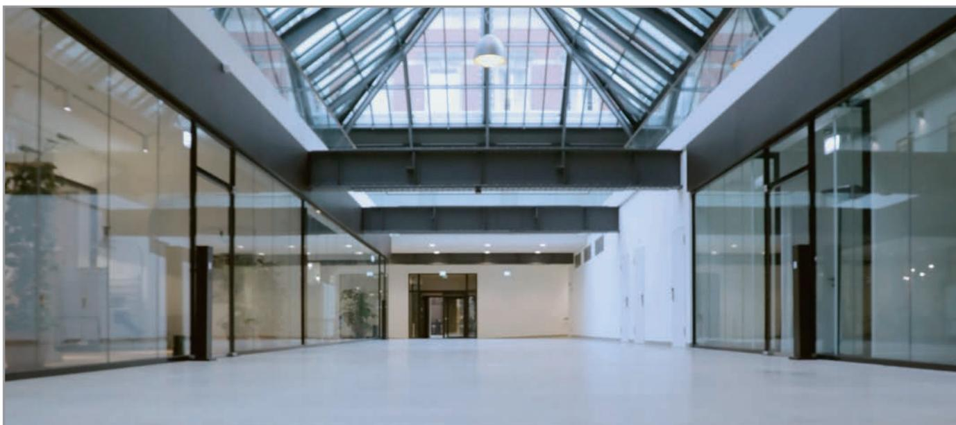
Die große Eingangshalle mit Galerie, die Treppenhäuser und die WC-Anlagen wurden mit Pandomo-Terrazzo gestaltet. Insgesamt galt es, den Terrazzoboden auf einer Fläche von 1.600 Quadratmetern und 300 Winkelstufen aufzubringen. Für die saubere Ausführung hat der Boden-Spezialist PANDOMO TerrazzoBasic und die graue Bindemittelmatrix PANDOMO BG eingesetzt.
