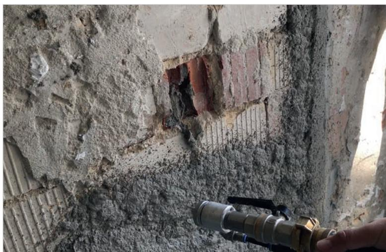
ARDEX A 930 ist sehr spannungsarm und kann in Schichten von 3 bis 30 Millimetern aufgetragen werden. Zudem hat das neue Mörtelprodukt eine lange Verarbeitungszeit. So ist der Wandmörtel nicht nur für die Hand- und Rollspachtelungen geeignet, sondern auch pumpbar. Das macht das Produkt auch für große Flächen interessant, die wirtschaftlich realisiert werden können.
