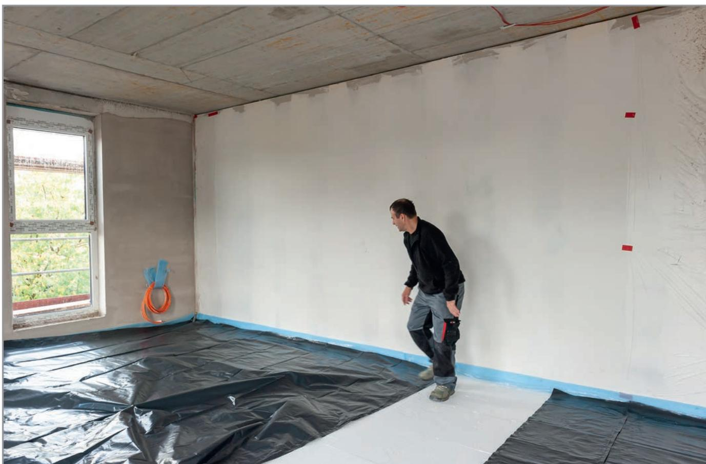
Im Fitnessbereich war ein erhöhter Schallschutz erforderlich: Zunächst wurde die Fläche mit Leichtausgleichsmörtel ausgeglichen. Darauf kamen die Trittschallmatte (Regupol Sound 12) und PE-Folie, bevor der Schnellestrich aufgebracht wurde.
