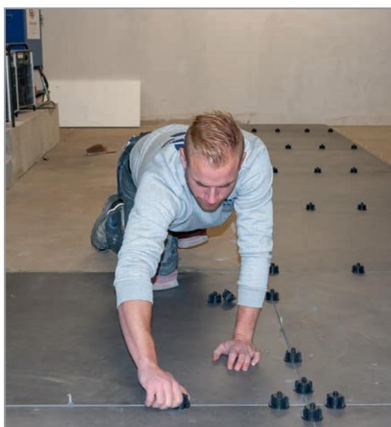
Die Fliesenarbeiten im Buttering-Floating-Verfahren erfolgten mit ARDEX X 78: Der Microtec-Flexkleber für die Bodenverlegung verbindet die Vorteile eines standfesten Klebers mit denen eines Fließbettklebers. Die Fliesenrückseite kann nahezu vollflächig benetzt werden. Daher ist der Kleber bestens für die Verlegung großformatiger Fliesen geeignet.
