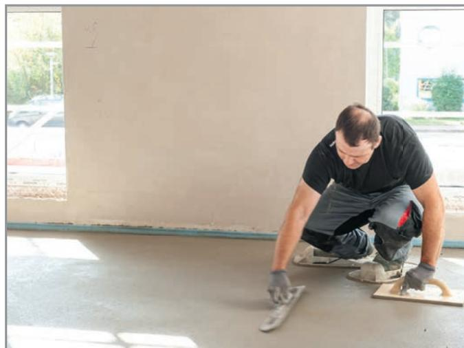
Der Estrichmörtel wird verteilt und verdichtet und mit der Latte abgezogen.
