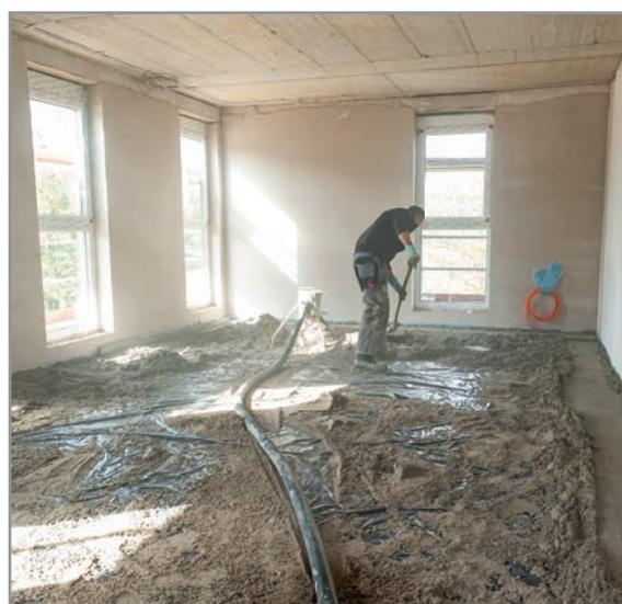
Der Schnellestrich ARDEX A 58 wird mit Sand und Wasser angemischt, in die Räume gepumpt und verteilt.
