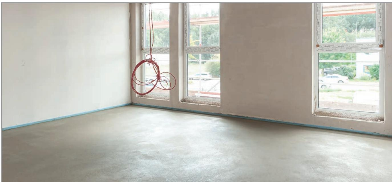
Auf einer Fläche von 1.600 qm über drei Etagen wurde im Zuge der Neubauarbeiten Estrich aufgebracht. Darauf kamen drei verschiedene Beläge: großformatige Fliesen, Vinyl und Echtholzparkett.
