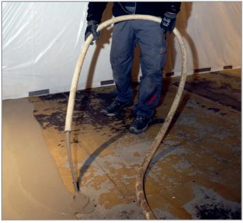
Die Spachtelmasse wurde mit der Pumpe verarbeitet, statt in einzelnen Eimern. Dafür eignet sich die zementäre Ausgleichsmasse ARDEX K 39 ideal. Große Flächen, wie hier rund 400 qm, lassen sich so einfach und schnell bearbeiten.
