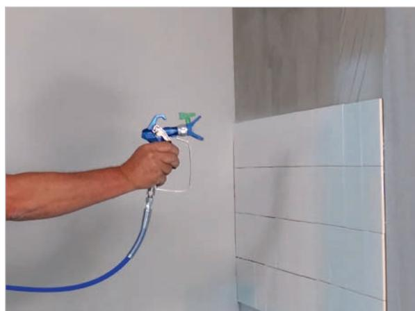
ARDEX P6 READY ist die erste spritzbare Dispersionsgrundierung im Ardex-Sortiment. Mit diesem Produkt schaffen Handwerker große Flächen in kurzer Zeit – bei effizientem Materialeinsatz. Das kornlose Material der neuen Grundierung schont die Maschinen. Für die Verarbeitung eignen sich besonders Maschinen, die auch für den klassischen Farbauftrag eingesetzt werden, etwa Airlessgeräte.
