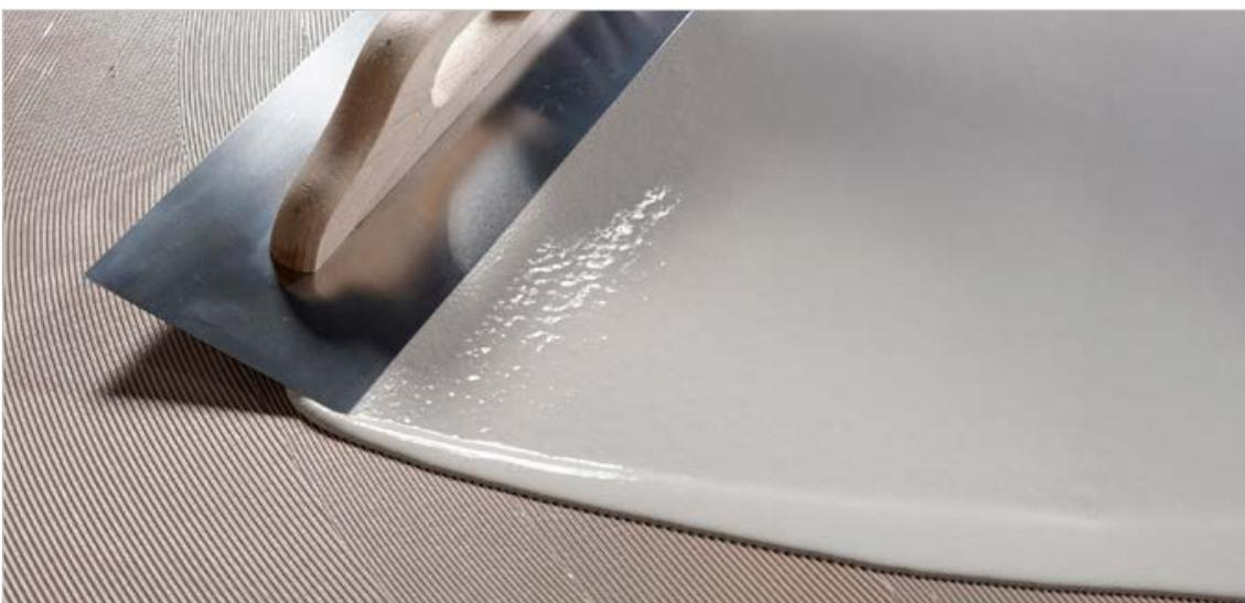
Das neue Ardex-Bindemittel basiert auf Zement, der veredelt wurde. Dadurch ist die gespachtelte Fläche innerhalb von zwei Stunden begehbar, obwohl die Verarbeitungszeit mit 30 Minuten recht lang ist. Gleichzeitig trocknet die Fläche nahezu ohne Schwund mit einer absolut glatten Oberfläche – ähnlich wie sonst nur gipsbasierte Bodenspachtelmassen. Der dadurch entstehende Untergrund ist extrem hart.
