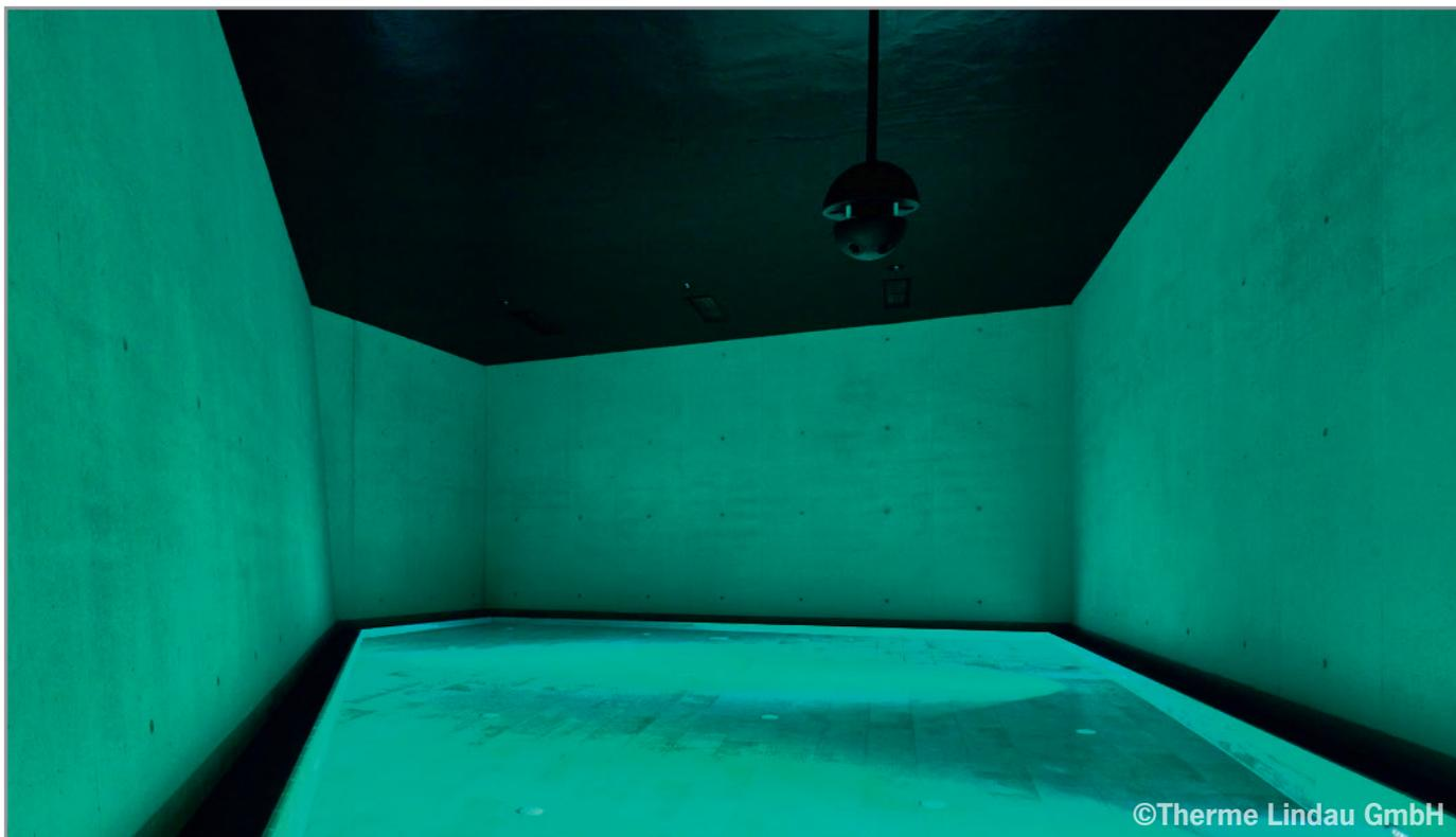
Eine weitere Herausforderung an die Abdichtung ist das Solebecken. Denn dies muss gegen die Mineralien und Salze beständig sein. Auch hier konnten die Fliesenleger mit der hochbelastbaren Abdichtung ARDEX S2-K PU arbeiten. Da damit nicht abgesandet werden muss, konnte Arbeitszeit gespart werden.
