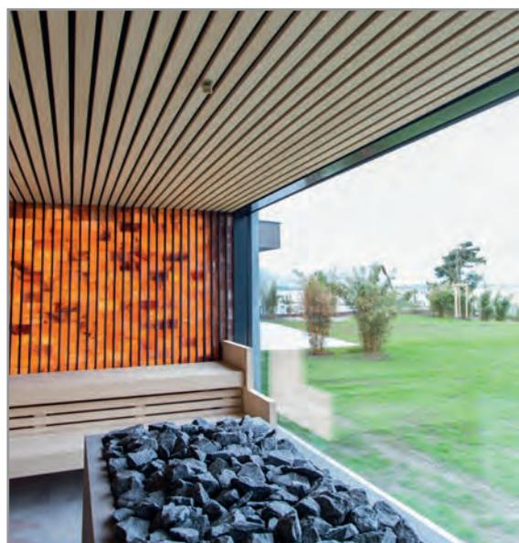
Alle Ummauerungen der Saunaöfen wurden mit Feinsteinzeugfliesen bekleidet. Dabei kam es darauf an, dass der Fliesenkleber hitzebeständig ist. Daher kam ARDEX X 77 zum Einsatz. Denn der faserarmierte MICROTEC Flexkleber ist ideal zum Kleben von Fliesen aus Steingut, Steinzeug und Feinsteinzeug, Beton- und Naturwerksteinplatten geeignet.
