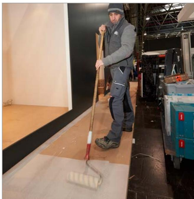
Der haftklebrige Rollklebstoff ARDEX AF 4000 wurde speziell für die Verlegung von Designbelägen entwickelt, etwa für PVC-Beläge im Fliesen- und Plankenformat oder Vinylbodenbeläge in Bahnen, im Fliesen- und Plankenformat. ARDEX AF 4000 wird nicht gespachtelt, sondern stehend mit der Rolle aufgetragen. Für die Verarbeiter ist das eine zusätzliche Erleichterung und ermöglicht ein ergonomisches Arbeiten.
