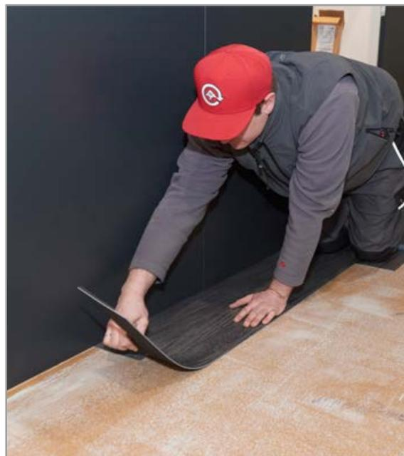
Aufgrund der leichten Verarbeitung und sofortigen Nutzbarkeit können die Verarbeiter einen Raum mit etwa 40 qm Bodenfläche problemlos in einem Arbeitsgang einwalzen und den Boden verlegen.
