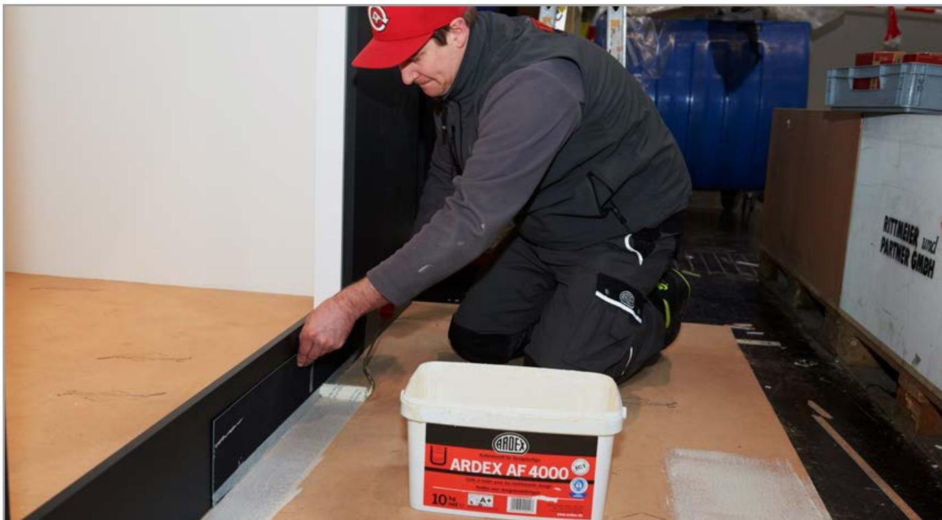
Der Boden war von der Messebau-Firma bereits mit speziellen Platten vorbereitet worden. So konnten die Spezialisten von Orth Fußböden aus Troisdorf den Boden direkt absaugen, die vorgegebenen Muster anzeichnen und mit dem Kleber loslegen.
