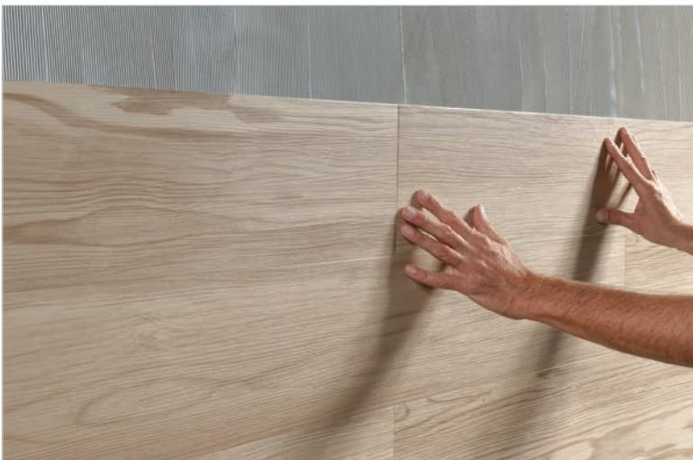
Hinzu kommt die einfache Verarbeitung: ARDEX AF 181W ist einkomponentig. Das bedeutet, der Klebstoff muss nicht angerührt werden und kann sogar mit der Rolle an der Wand aufgetragen werden.
