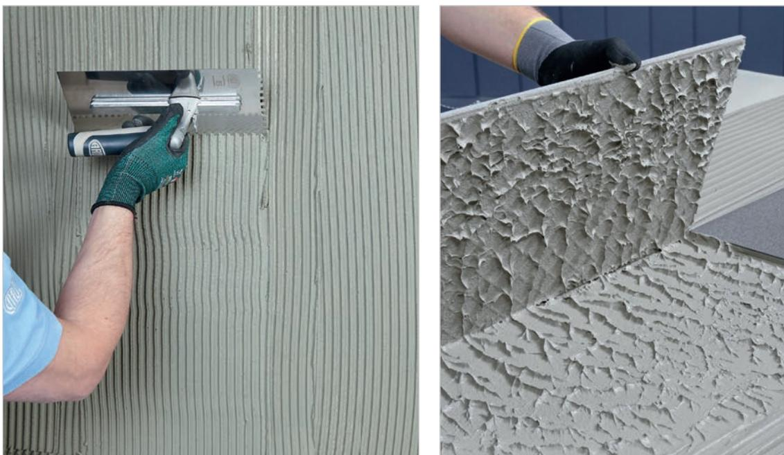
Ergänzt wird das Fliesenklebersortiment durch das Multitalent ARDEX X 80. Verarbeiter können mit nur einem Kleber einen großen Teil der anfallenden Arbeiten erledigen. Durch die lange Einlegezeit von bis zu 50 Minuten und die optimale Benetzung ist der Fliesenkleber besonders für Großformate geeignet.
