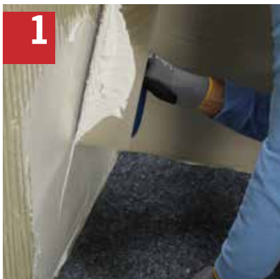
1 Untergrund spachteln mit ARDEX R1 Renovierungsspachtel.
