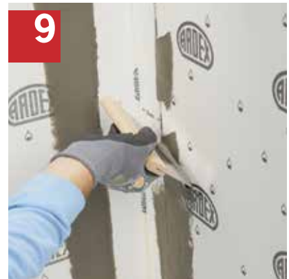
9 Übergänge an der Wand glätten mit ARDEX FIX Blitzspachtel.
