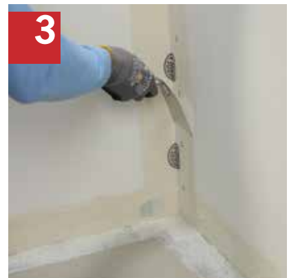
3 ARDEX TRICOM 12 Dichtband verkleben mit ARDEX AF 181 W.
