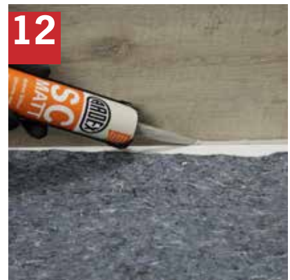
12 Fugen mit Silicon verschließen.
