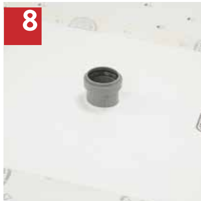
8 ARDEX TRICOM Bodenmanschette verkleben mit ARDEX AF 181 W.
