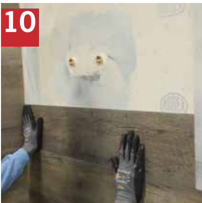
10 PVC-Designbelag an der Wand verkleben mit ARDEX AF 181 W. Wir empfehlen das abschliessende Aufbringen einer Schutzversiegelung auf den PVC-Designbelag.
