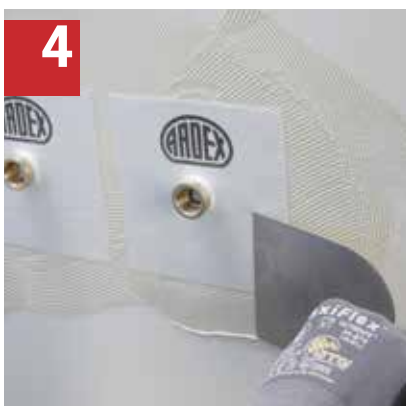
4 ARDEX TRICOM Manschetten verkleben mit ARDEX AF 181 W.
