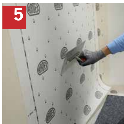
5 Wandflächen abdichten mit ARDEX SK 100 W Dichtbahn und ARDEX AF 181 W.
