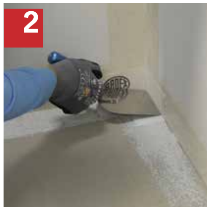
2 ARDEX TRICOM Dichtecken verkleben mit ARDEX AF 181 W.
