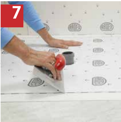
7 Bodenflächen abdichten mit ARDEX SK 100 W Dichtbahn und ARDEX AF 181 W.
