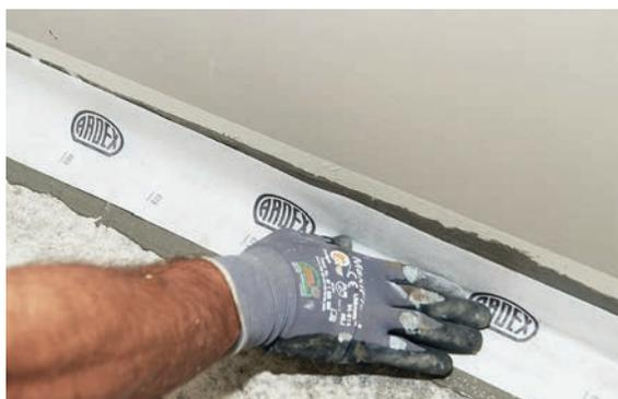
Im dauernassen Wandbereich der Wellnessbäder kam die flexible Dichtschlämme ARDEX S 7 PLUS zum Einsatz. Die lange Verarbeitungszeit und die gleichzeitig schnelle Verlegbarkeit nach vier Stunden haben für eine komfortable Verarbeitung gesorgt.
