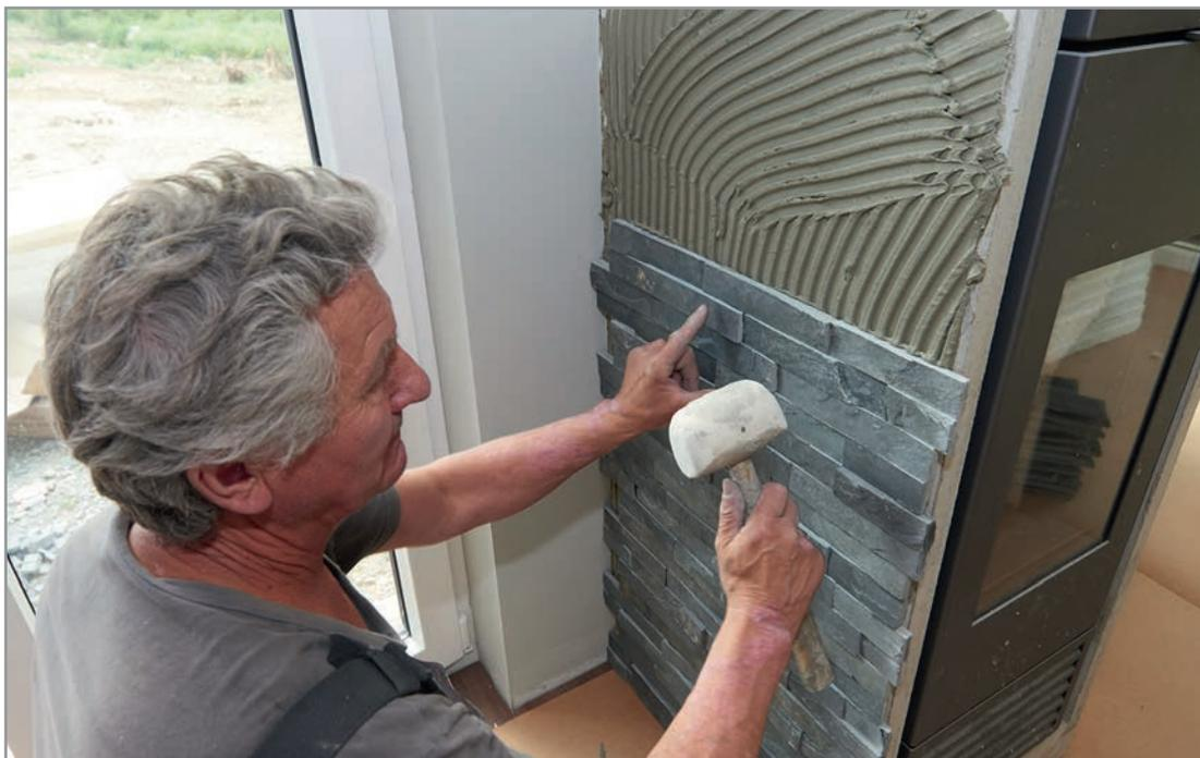
Auch für die Quarzitsteine an den Kaminen war der Microtec Flexkleber ARDEX X 77 hervorragend geeignet. Denn er hat auch bei Temperaturschwankungen eine hohe Klebekraft. Dank der ARDEX MICROTREC-Technologie werden Scherspannungen kompensiert, die Haftfestigkeiten verbessert und die Verformungskräfte reduziert.
