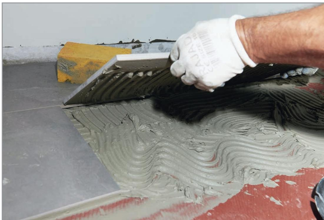
Die Böden der Wellnessbäder wurden mit großformatigen Fliesen belegt. Für sämtliche Fliesen haben die Handwerker den Microtec Flexkleber ARDEX X 77 verwendet.
