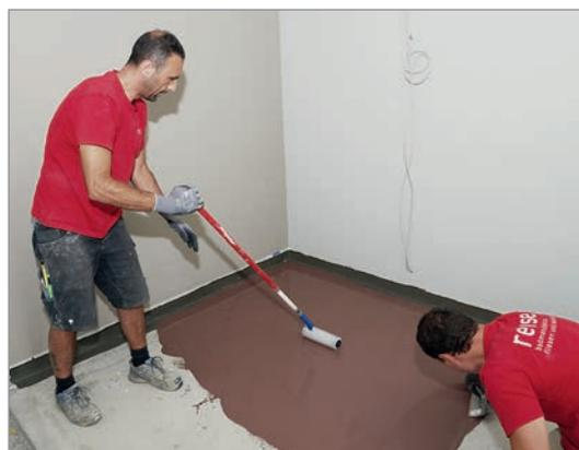
Die Mitarbeiter wurden vor Ort zur Anwendung der selbstverlaufenden Abdichtung ARDEX S 8 FLOW geschult. Bei den Holzständerbauten im Park Allgäu muss der Untergrund für die Fliesen vor Feuchtigkeit geschützt werden. Die Fliesenleger konnten ARDEX S 8 Flow sogar im Stehen verarbeiten – was bei einer Fläche von 6.700 Quadratmeter besonders geschätzt wurde. Da die Abdichtungsmasse selbst verläuft, wird der Boden besonders glatt.
