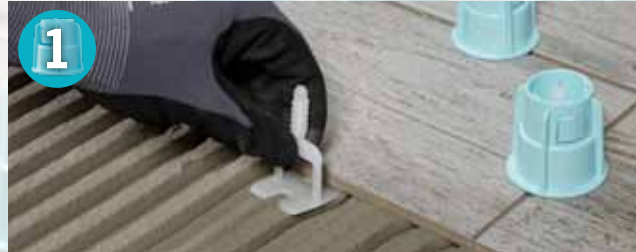
1 Einsetzen der Gewindelaschen
