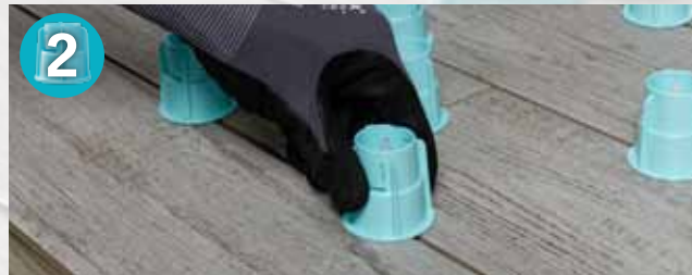
2 Drehknopf mit intelligentem Raster aufstecken und mit ca. 1-2 Umdrehungen kräftig fixieren
