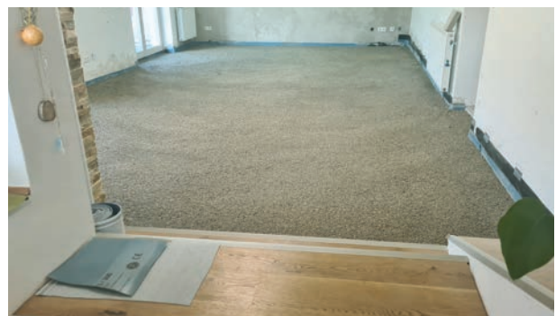
Tag 1: Einbau TB 400 power
