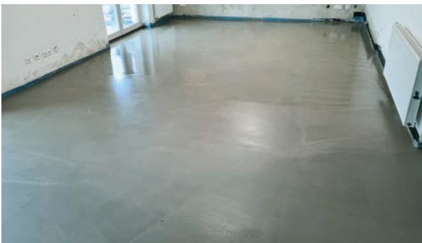
Tag 2: Aufbringung Nivelliermasse
