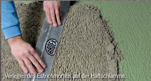
Verlegen des Estrichmörtels auf der Haftschlämme.
