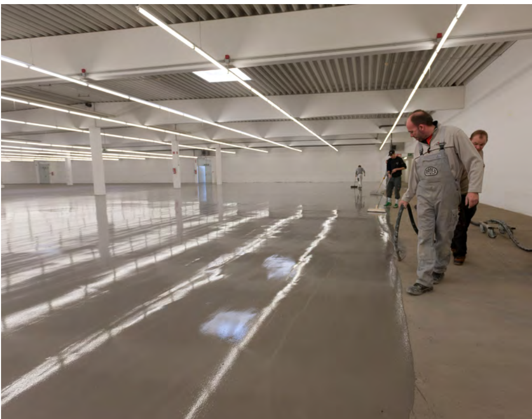
Herstellen einer Nutzschrift mit dem Dünnestrich ARDEX K 80 in einer Lagerhalle.
