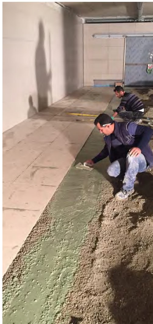
Verlegung von Fliesen mit ARDEX A 18 auf frischem Estrich.
