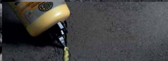
4. ARDEX P 10 SR präzise und sauber verfüllen
