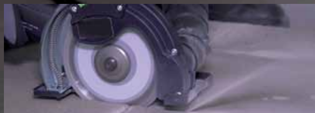
1. Riss aufweiten und Querschlitz einschneiden
