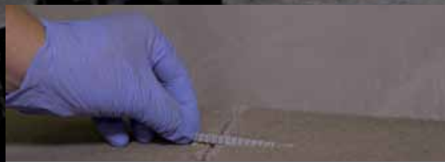
2. Wellenverbinder einlegen
