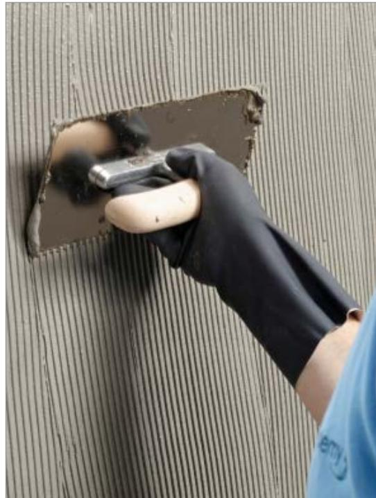
Zusätzlich hat Ardex die erfolgreiche Dichtschlämme ARDEX S7 optimiert, beispielsweise die Standfestigkeit verbessert und die Konsistenz noch geschmeidiger gemacht. Hinzu kommt die Faserarmierung. Die Abdichtung ist jetzt bis 5 bar druckwasserdicht.
