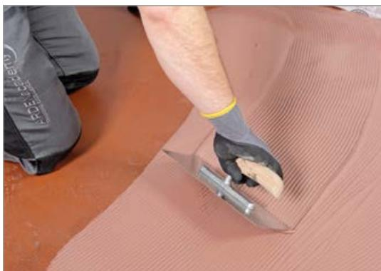
ARDEX S8 FLOW kann als Abdichtung unter Fliesen und Platten auf Bodenflächen im Innen- und Außenbereich sowie in Schwimmbecken verwendet werden.
