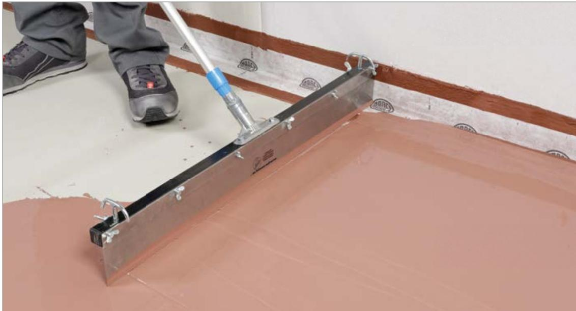
Weltneuheit aus Witten: Ardex hat mit ARDEX S8 FLOW die erste selbstverlaufende einkomponentige Abdichtung entwickelt. Verarbeiter können sie bequem im Stehen auftragen – durch die guten Verlaufs- und Glätteigenschaften geht das schnell und einfach. Zudem kann die neue Abdichtung bis zu einer Schichtstärke von 5 mm eingesetzt werden und dabei leichte Unebenheiten direkt mit ausgleichen.
