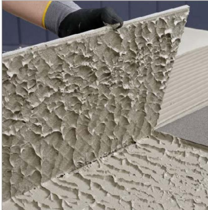
ARDEX X 90 OUTDOOR ist auch bei niedrigen Temperaturen ab rund 5 Grad Celsius einsetzbar. Dabei behält das Produkt alle Eigenschaften eines schnellen Flexklebers bei. Ein weiterer wichtiger Vorteil ist die vollflächige Benetzung. Dadurch liegen die Fliesen nicht hohl, Schäden werden sicher vermieden.
