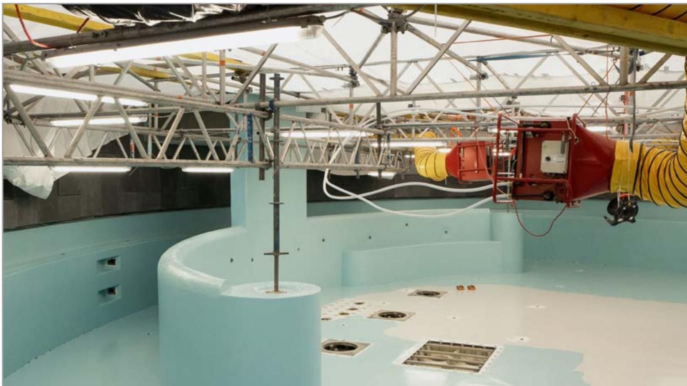
Ein eigens aufgebautes Dach samt Heizung sorgte auch in den Wintermonaten für eine gleichbleibende Temperatur bei der Verarbeitung und für trockene Verhältnisse.
