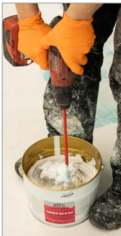
Die Mineralien und Salze des Thermalwassers greifen die Materialien an. Daher haben die Bodenspezialisten die hochbelastbare 2-komponentige Abdichtung ARDEX S2-K PU eingesetzt. Absanden ist nicht notwendig.
