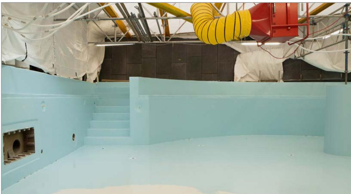
Das Material wurde normgerecht in zwei Schichten aufgetragen. Dadurch wird die Mindestschichtstärke erreicht. Um Fehlstellen in der zweiten Schicht zu erkennen, wird das Material vor dem zweiten Auftrag eingefärbt.
