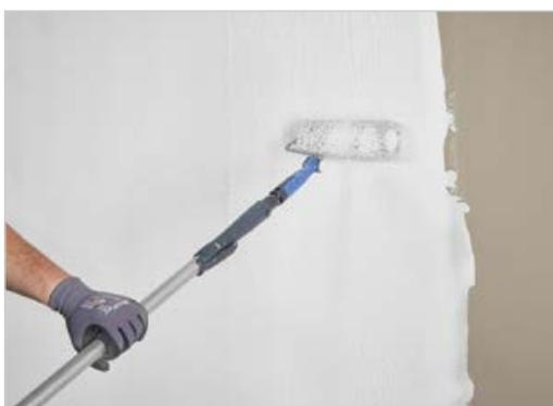
ARDEX A 800 READY eignet sich bestens für die Maschinenverarbeitung und damit für große Flächen – und somit für den Objektbereich. Auf eine Grundierung kann bei vielen Untergründen verzichtet werden. Der Flächenspachtel lässt sich bis auf Null ausziehen und kann bis zu einer Schichtstärke von 6 mm eingesetzt werden. Damit ist der neue Dispersionsspachtel eine ideale Systemergänzung zum Wandfüller und Flächenspachtel ARDEX A 828, der auf nahezu allen Baustellen zu finden ist.
