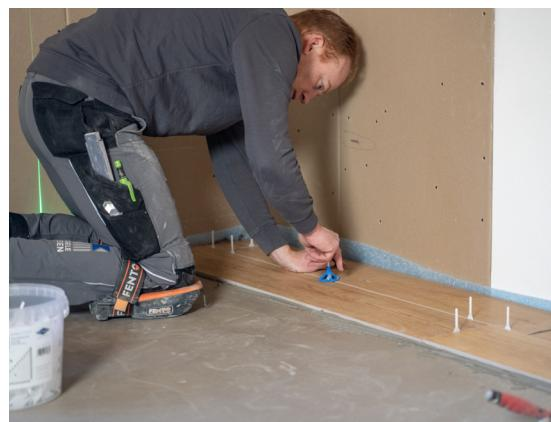
Zusätzlich ist auf dem Leichtestrich von Ardex auch die Verlegung von Großformaten möglich. Ardex gibt ihn für Großformate bis 1 m x 1 m frei. Das Produkt ist zudem für alle gängigen Beläge geeignet, auch für Designbeläge oder Parkett. In der neuen Dachgeschosswohnung konnten in dreieinhalb Tagen zwei verschiedene Fliesenbeläge verlegt werden.
