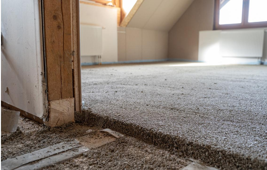
Mit seinem geringen Gewicht stellt der Leichtestrichsystemboden ARDEX STRONGLITE eine starke Alternative zu den viel schwereren Nassestrichen dar. Der Einbau spart mindestens zwei Drittel des Gewichts. Bei der minimalen Aufbauhöhe von 18 mm im Verbund beträgt das Flächengewicht von ARDEX STRONGLITE lediglich 27 kg pro Quadratmeter.
