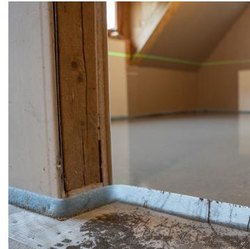
Das Fliesenlegerteam führte zunächst den Einbau der in einem Mischgerät angerührten gebundenen Leichtschüttung ARDEX LS durch. Am nächsten Tag konnte das bewährte Armierungsgewebe ARDEX BU-R verlegt und anschließend der Dickschichtausgleich ARDEX K 71 als Systemkomponente selbstverlaufend ausgebracht werden.
